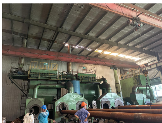
FQ-010、FQ-011、FQ-012 排气筒废气处理设施：旋风+脉冲布袋除尘
