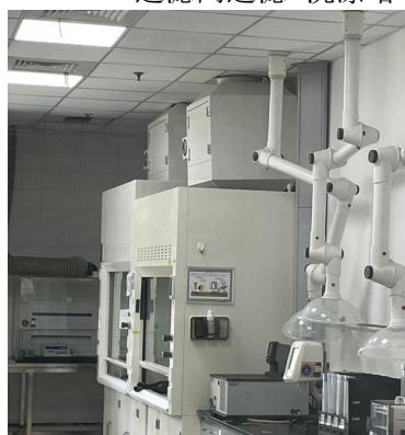
检验废气中效过滤器+活性炭过滤器装置
