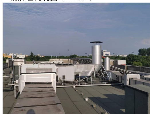
检验废气中效过滤器+活性炭过滤器装置
