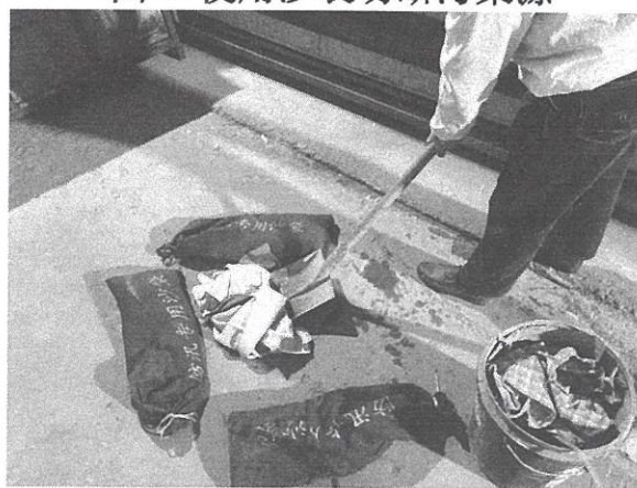
图 5 使用棉布处理污染物
