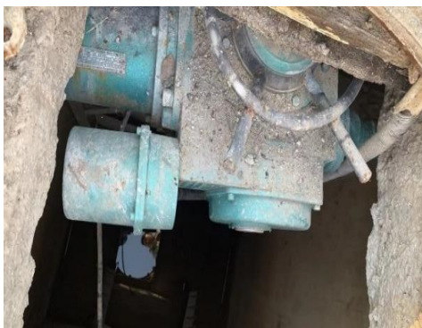
3#雨水切断阀
