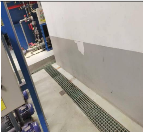
工业污水处理站内四周设置导流沟以及收集池
