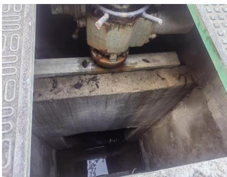
1#雨水切断阀
