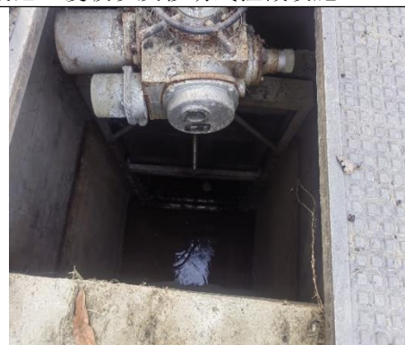
2#雨水切断阀
