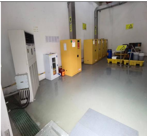
危废仓库（防爆柜、托盘、导流沟、收集池、漫坡以及移动式拦截设施）
