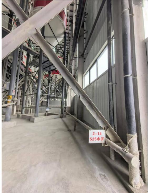
水泥及粉煤灰输送带全封闭
