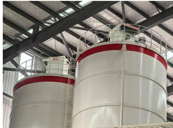
仓顶式脉冲袋式除尘器 (筒仓)
