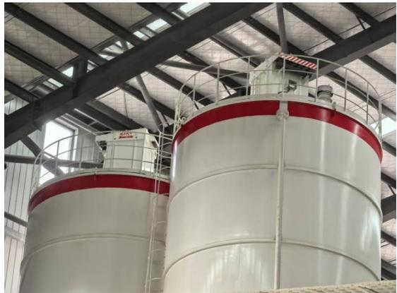
罐顶高效脉冲除尘(水泥/粉煤灰储存罐区)
