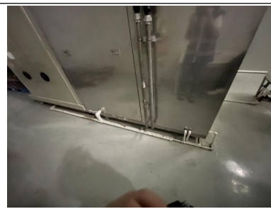
清洗车间地面防腐地坪
