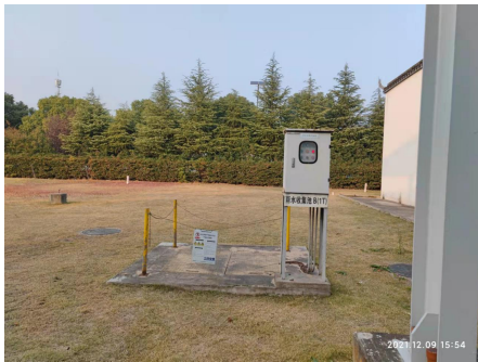
初期雨水收集池
